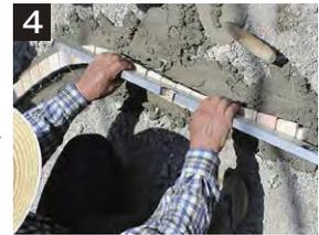
4 商品を置き、水平機で土間面の高さに合わせます。
