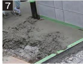
7 石をテープ養生し土間を打ち、コテで均し面取りします。(土間は石の面より1~2mm程度下げます)
