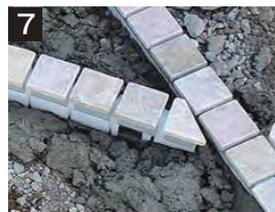
7 ストレートタイプとアールタイプが交差する箇所の施工はアールタイプの石部分を取り外し、角度を合わせ切り取って施工してください。
