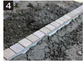
4 両側にモルタルで商品を固定します。(目地なしタイプは施工工程の7に進みます。)
