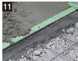
11 石をテープ養生し土間を打ち、コテで均し面取りします。(土間は石の面より1~2mm程度下げます)
