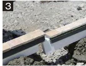
3 つなぎ施工の際はレールと土台をずらして(10cm以上推奨)ジョイントします。
