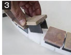
3 Rの曲がり具合によって石を取り外し、目地の広さを調整してください。(石部分は仮止めのため、自由に取外し可能です。)
