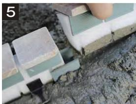
5 つなぎ施工の際はアールタイプに付属している「コ」の字型部材を下にはめ、ジョイントしてください。
