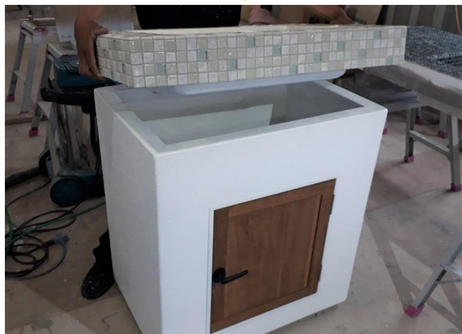
②シンク天板をかぶせます。
