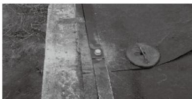
穴あけの際のコンクリートの粉を除去し、インパクトドライバーでアンカーをねじ込みます。2本目のフラットバーを連結して固定し、最後に中間部を固定し、全て固定したら施工完了となります。
