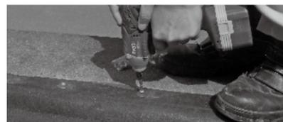
穴あけの際のコンクリートの粉を除去し、インパクトドライバーでワッシャーとともにビスをねじ込み、施工完了となります。
