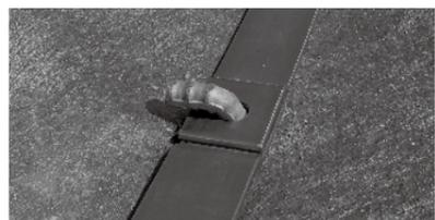
残りの穴をL型止めピンで固定し、施工完了となります。
