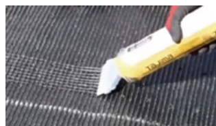
タコ足ノズルで施工
