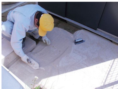
敷き均し作業
