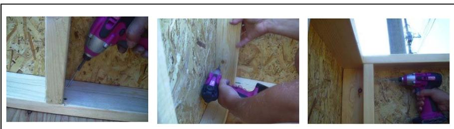
内側から、床・壁のスタッドに20センチ間隔で75ミリビスを打ちます。
