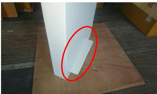
①側面ボード下部のアンクル部分に穴をあけアンカーボルトで固定します。
