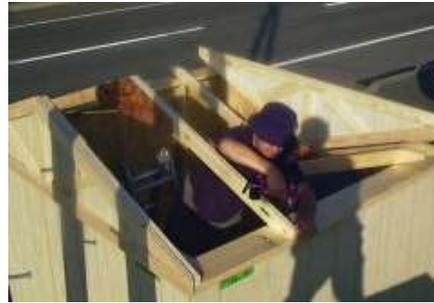
垂木の角が上枠の端から出ないように印に合わせながら、75ミリビスを3本ずつ止めます。3組とも両サイドを止め、前の妻壁パネルも止めます。
