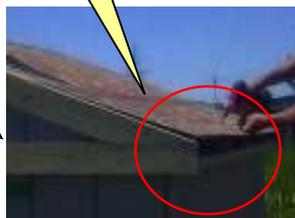
『野地板A』を『野地板B』の下に合わせ、同じように、線を引いて、20センチ間隔で41ミリビスを打ちます。
