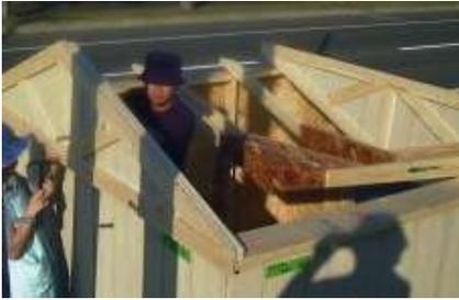
妻壁パネルをフロントパネル・リアパネルにそれぞれ乗せ、妻壁パネルを内側から、75ミリビスで15センチ間隔に打ちます。
