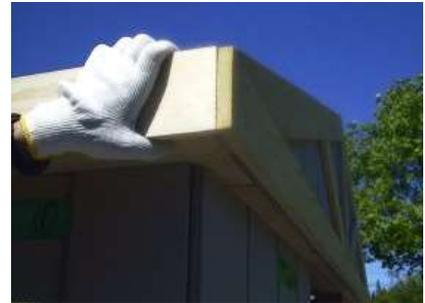
しっかり押さえ、スリム40ミリのビスで上下2本ずつ、左の図のように止めます。反対側も同じように止めます。
