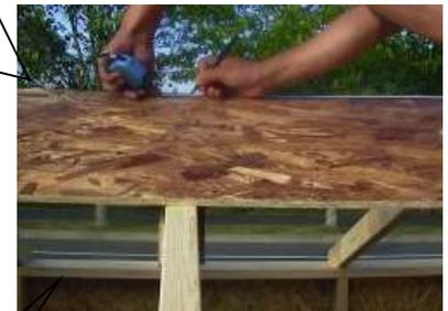
『野地板B』を屋根に乗せ、上と角を合わせてから、スケールで計り、野地板Bに垂木の上の部分に印を付けます。下も同じように計り、線を引きます。
