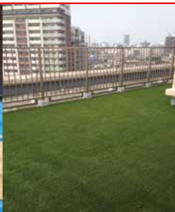
施工完了後の様子
