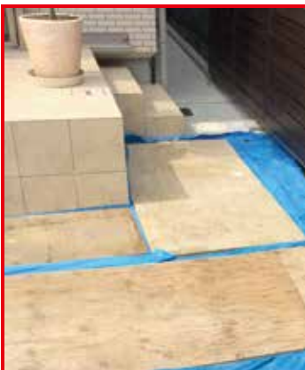
圧着・養生の様子
