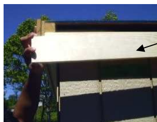
軒に『破風』を当て、長さを測り、印を付けます。
