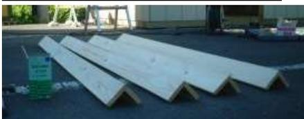
図のようにトリムを取り付けます。スリムビス25mmで20センチ間隔に止めます。
