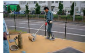
二次転圧(ローラー転圧)作業
