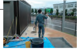
一次散水作業
