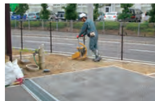
下地基盤整正・転圧作業
