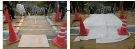
冬の凍結防止のための保温マット設置事例
