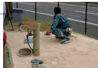
一次転圧作業・不陸調整作業
