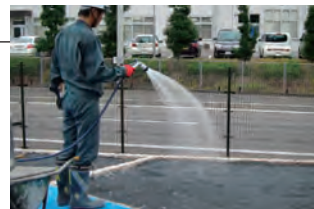
下地散水作業
