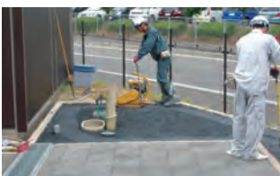
砕石敷き均し・転圧作業
