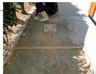
施工打ち継ぎ目(角材止め)
