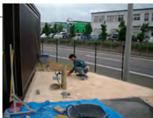
敷き均し作業
