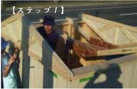
妻壁パネルをフロントパネル・リアパネルにそれぞれ乗せ、妻パネルの内側から75ミリビスを15センチ間隔で打ちます。
