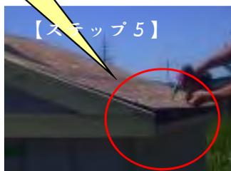
『野地板A』を野地板Bの下に合わせ、同じように、線を引いて、15センチ間隔で41ミリビスを打ちます。
