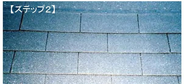
2段目からは1段目に半分重ね、半分ずらして、貼っていきます。シージングネールを接着剤の上に、15センチ間隔で打ちます。
