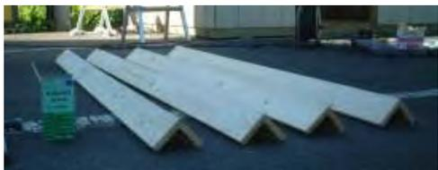
コーナートリムを下図のように配置します。それぞれ、スリムビス25mmを20センチ間隔で止めます
