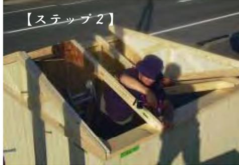
垂木の角が上枠の端から出ないように印に合わせながら、75ミリビスを3本ずつ止めます。3組とも両サイドを止め、前の妻パネルも止めます。
