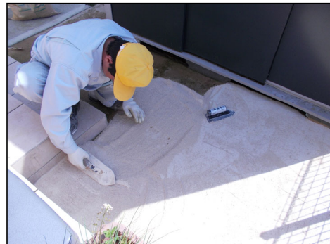
敷き均し作業
