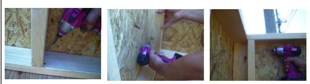
内側から、床・壁のスタッドに20センチ間隔で75ミリビスを打ちます。
