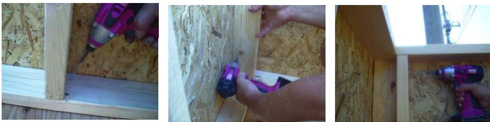
内側から、床・壁のスタッドに20センチ間隔で75ミリビスを打ちます。
