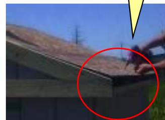
『野地板』を15センチ間隔で41ミリビスを打ちます。
