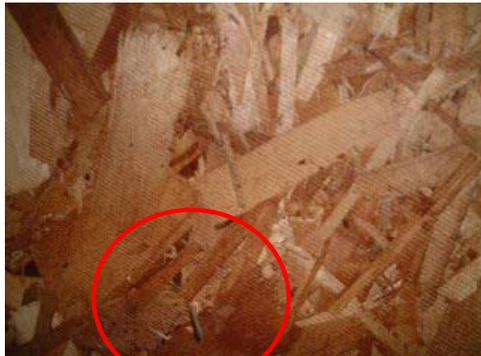
物置の内側はアスファルトシングルを打った釘が出ますので、金槌で釘の先を曲げておくと安全です。
