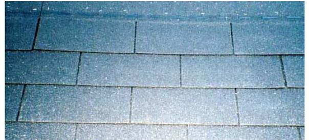
2段目からは1段目に半分重ね、半分ずらして、貼っていきます。シージングネールをノリの上に、15センチ間隔で打ちます。
