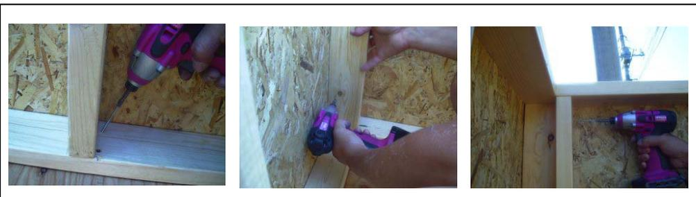
内側から、床・壁・天井のスタッドに15センチ間隔で75ミリビスを打ちます。
