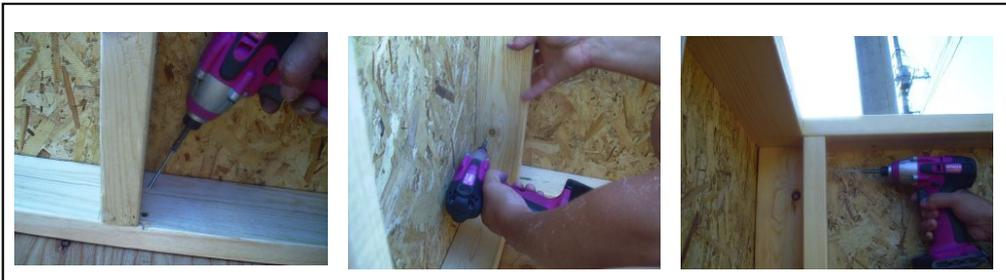
内側から、床・壁・天井のスタッドに15センチ間隔で75ミリビスを打ちます。
