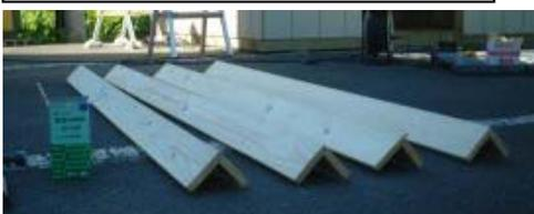
図のようにトリムを取り付けます。スリムビス25mmで20センチ間隔に止めます。
