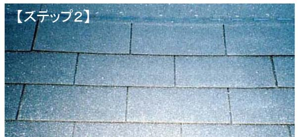
2段目からは1段目に半分重ね、半分ずらして、貼っていきます。シージングネールを接着剤の上に、15センチ間隔で打ちます。
