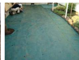
②エクシスランド防草シートの敷設
