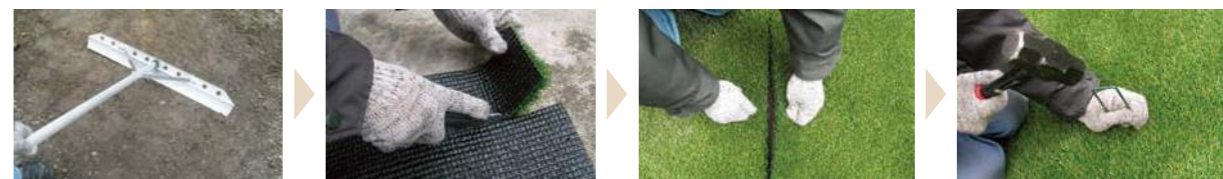
①下地調整 ②カット ③人工芝の仮敷き ●裏のパッキングが出すぎている場合、カットすると繋ぎ目が目立ちにくくなります。 ④固定(U字ピンなどによる固定)
