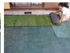
③リアリーターフの敷設
